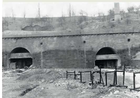
Entrée des tunnels de l'usine souterraine de Leonberg, annexe de Natzweiler.
